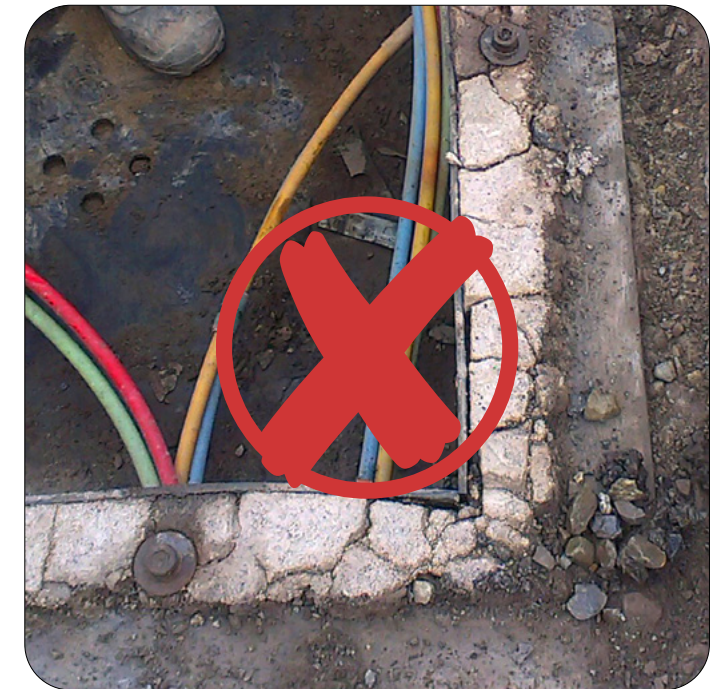
Herkömmlicher Mörtel hält den Belastungen des Straßenverkehrs nicht Stand.
